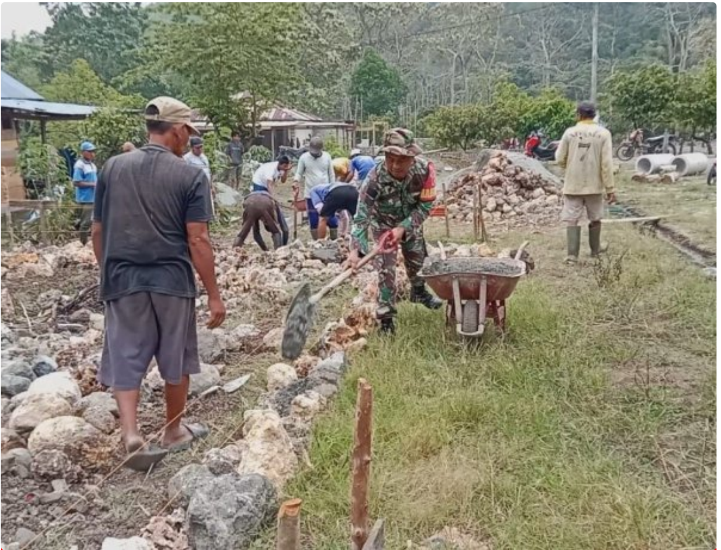
Gotong royong bangun pondasi rumah warga
